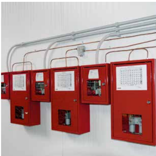
Rys. 1 Przykładowe zastosowanie pneumatycznych systemów sterowania oddymianiem
