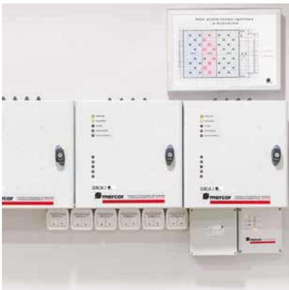
Rys. 2 Przykładowe zastosowanie elektrycznych systemów sterowania oddymianiem
